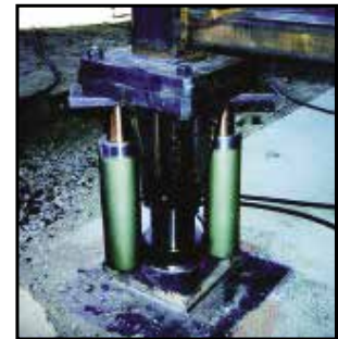
Los contratistas recurrieron a la fuerza bruta de los cilindros Simplex R5513 para levantar y posicionar las rampas de una carretera en San Diego. G6 suministró la potencia y el control para esta difícil aplicación al aire libre.
